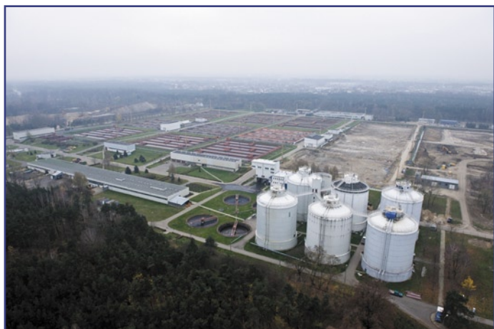
Rozbudowa i modernizacja oczyszczalni Czajka w Warszawie
